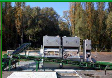
Station de dégrillage
